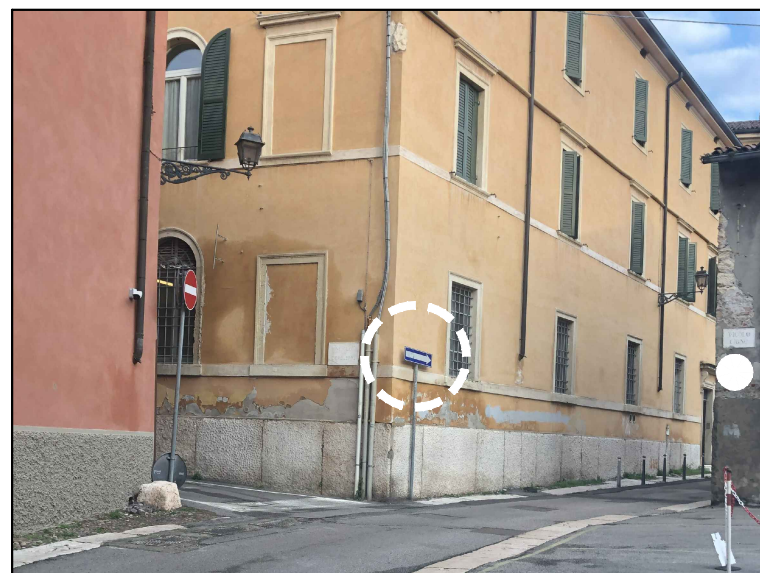
SV: sostituzione "senso unico" con "senso vietato" installazione "senso vietato"
